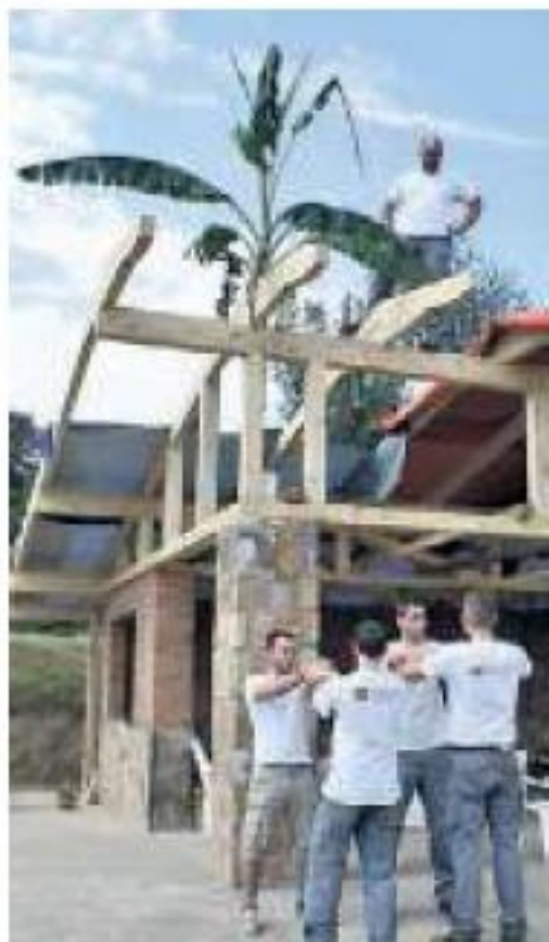
In Ruanda unbekannt: Zimmermannsklatsch. In Frankenberg unbekannt: Richtfest mit Bananenbaum.
